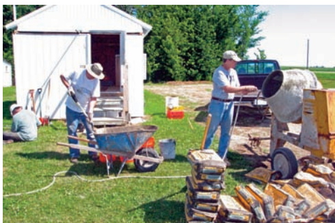
CGO pier pour - cement mixer July 11 2009
